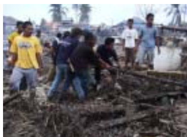
瓦礫の除去作業を行う住民
